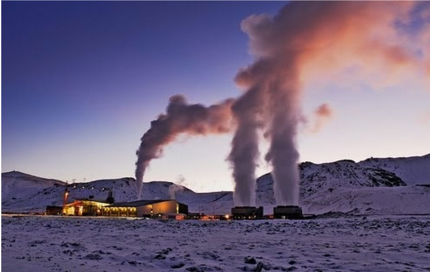
Central Geotérmica em Hellisheidi (Reykjavík - Islândia)
