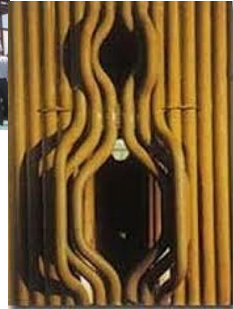
Figura 11.17 Paredes de água
