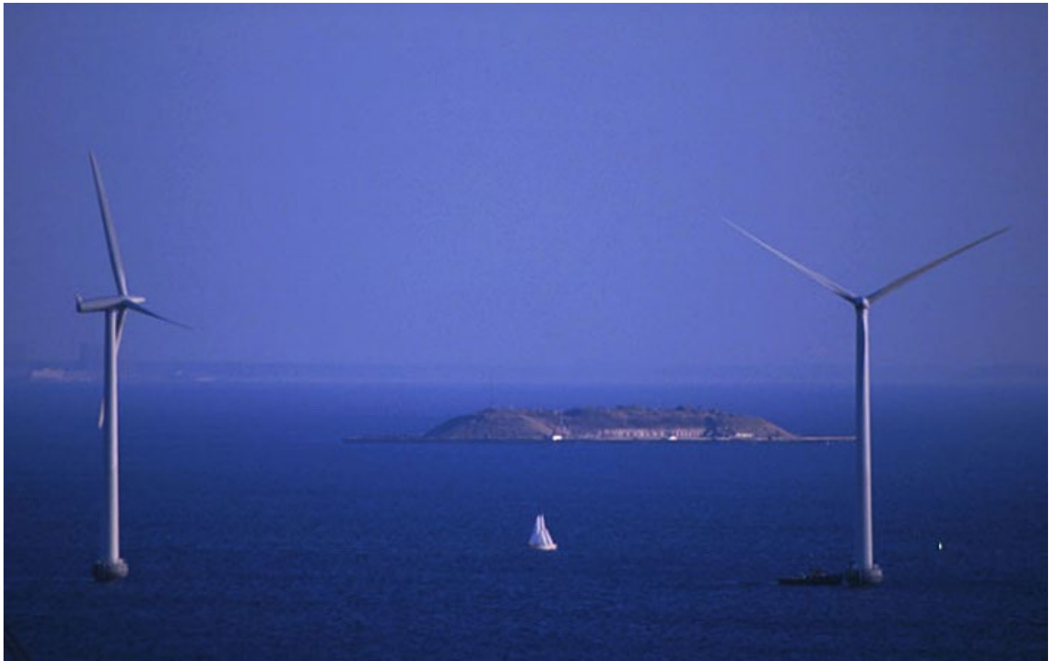
Fig 23.16 – Parque eólico offshore (Dinamarca).
