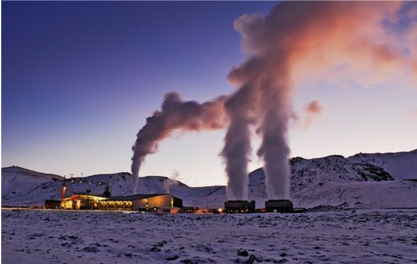
Central Geotérmica em Hellisheidi (Reykjavík - Islândia)
