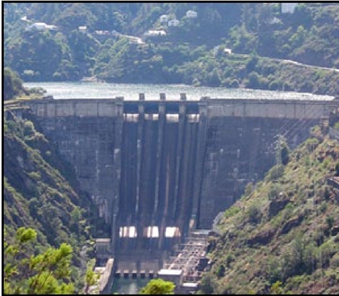
Imagem de uma Barragem
