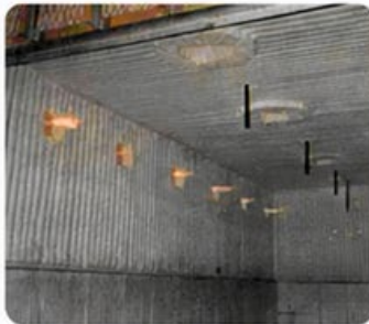
Revestimento lateral e tecto.
